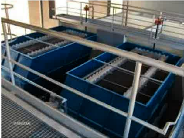
Immagine 7: decantatori lamellari in serie
