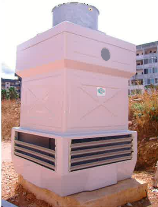
Immagine 2: torre evaporativa dalle dimensioni contenute
