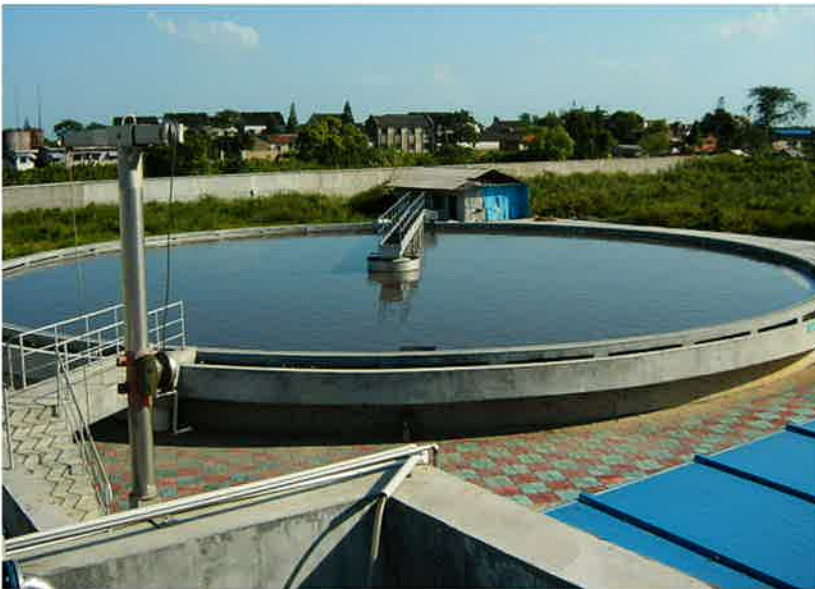
Immagine 6: gigantesco decantatore circolare a fondo conico
