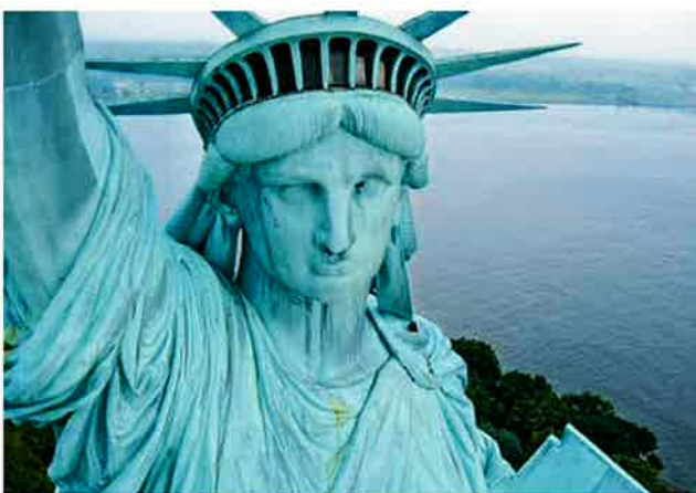
Immagine 4: La statua della libertà e lo strato da autopassivazione del rame che la riveste
